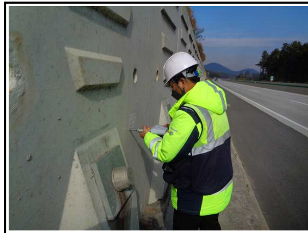
【그림 7.3.6】 슈미트해머를 이용한 반발경도시험 전경
